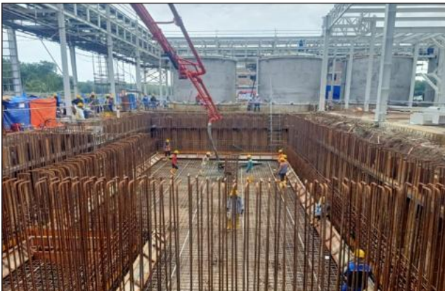
Pouring Concrete Slab WTP
