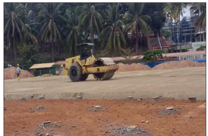
Crusher Run/Duststone Layer
